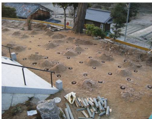
割竹工法 (坪穴に改良材と空気の竹)
