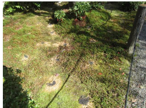
施工完了（景観仕上げは別途工法）
