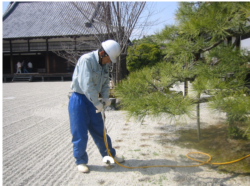
土壤灌注作業
